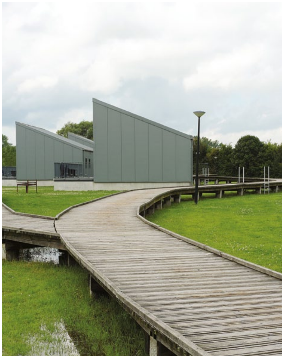
Deze woningen op kolommen in recreatiedomein De Gavers zijn bestand tegen overstromingen.
