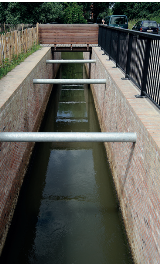
Het uiteindelijke tracé van de vistrap loopt in een diepe geul tussen de molen en de straat.
