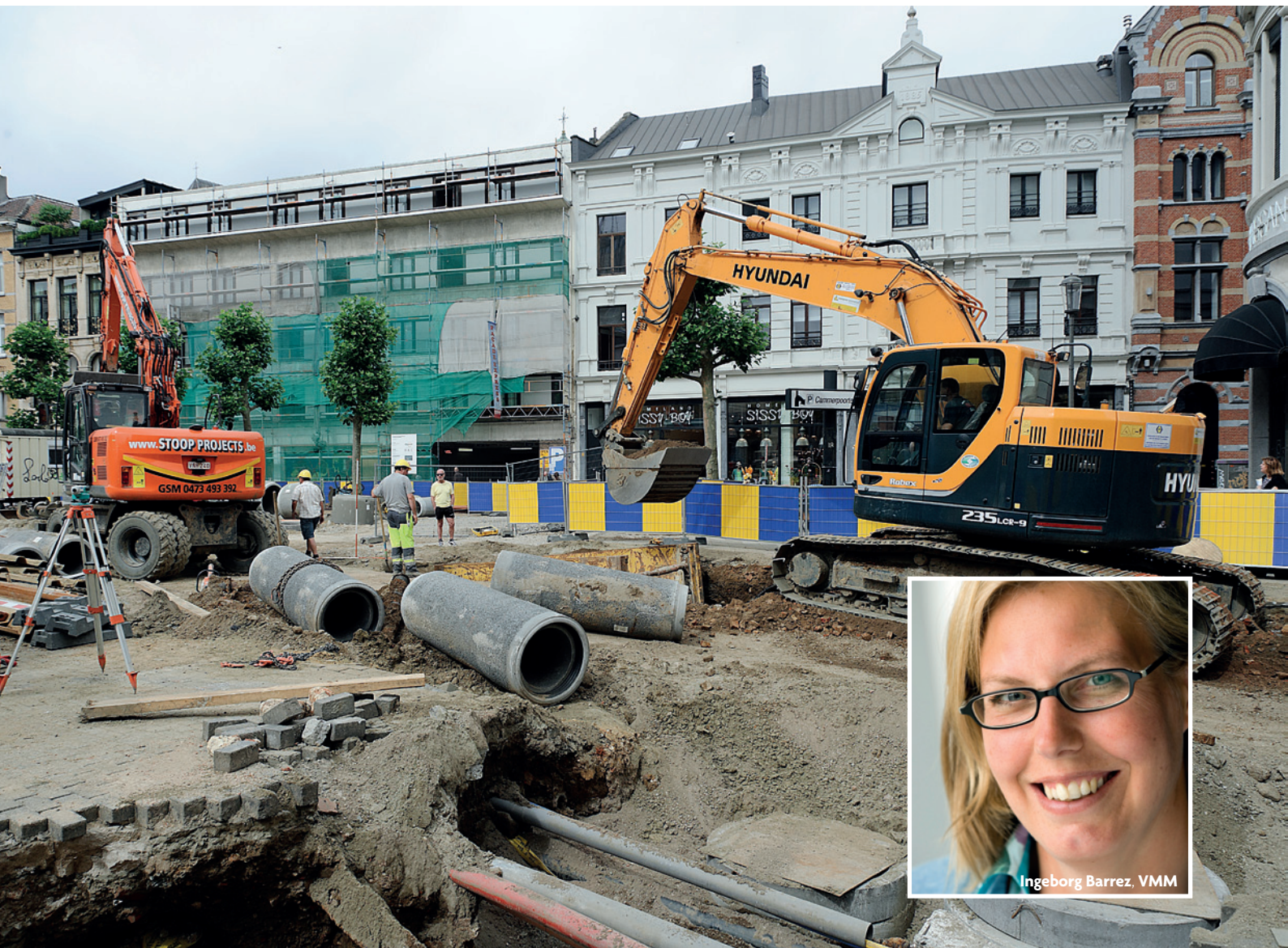
De kostprijs om rioleringen aan te leggen en te onderhouden loopt al snel op tot 700 euro per lopende meter.
