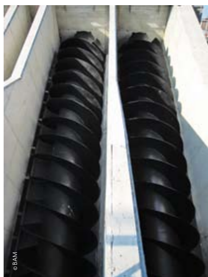
(foto links en rechts) Vijzels verplaatsen een groot deel van het water naar het Lobroekdok.
