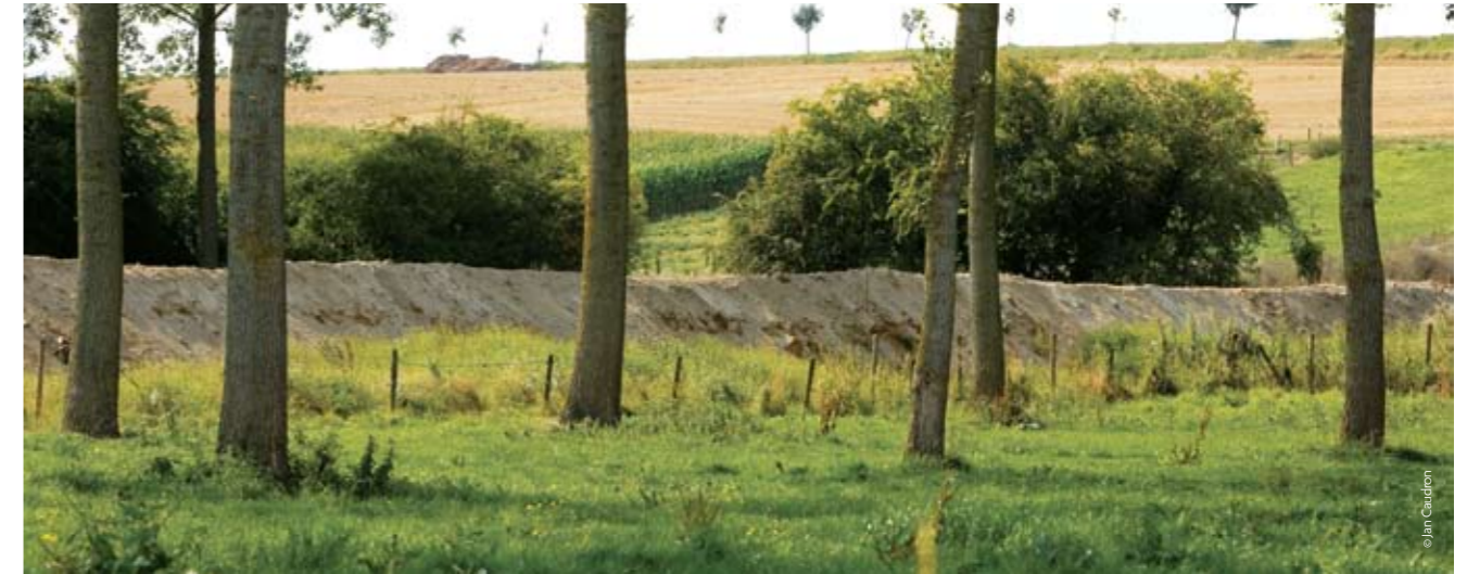
Een nieuwe dijk in de vallei, dwars op de Jeker, houdt het water tegen.
