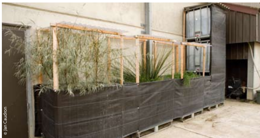
Biofilter met drie bakken waarin gras, zegge en wilgen groeien.
