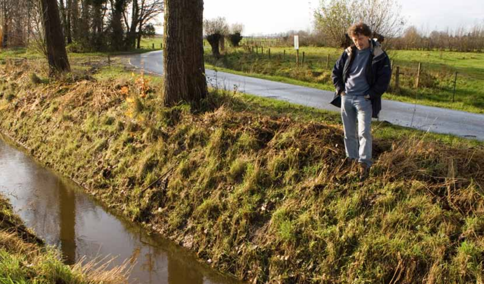
Een gedeelte van de Merlebeek dat niet heringericht is.
