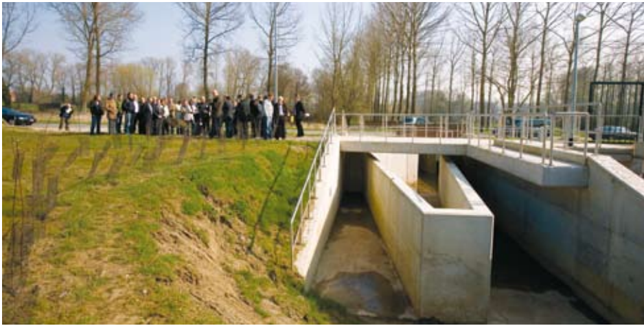
De noodoverlaat van het gecontroleerd overstromingsgebied in Erpe-Mere
