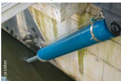
De afsluitklep in de stuw wordt hydraulisch aangedreven.
