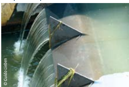
Detail van de afsluitklep in de stuw.
