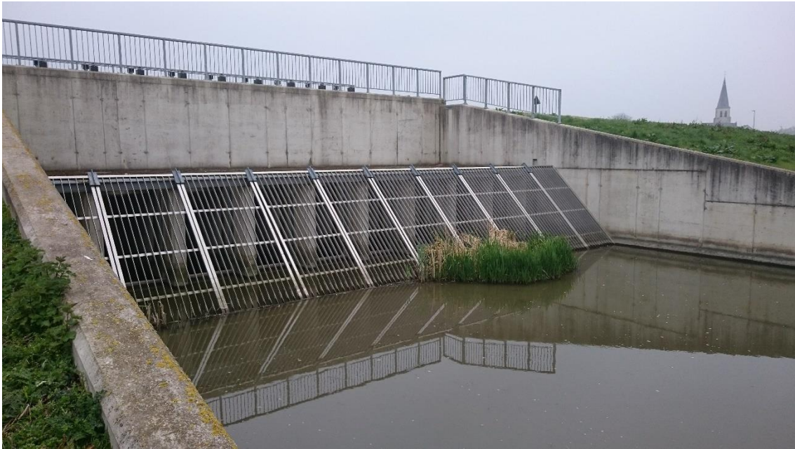
Foto 2 De uitwateringssluis aan de Sompelbeek KM8.
