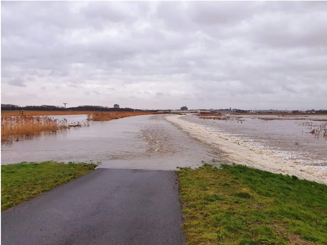
Foto 9 Het water loopt over de overloepdijk tijdens storm Ciara (Foto Franky Dens).
