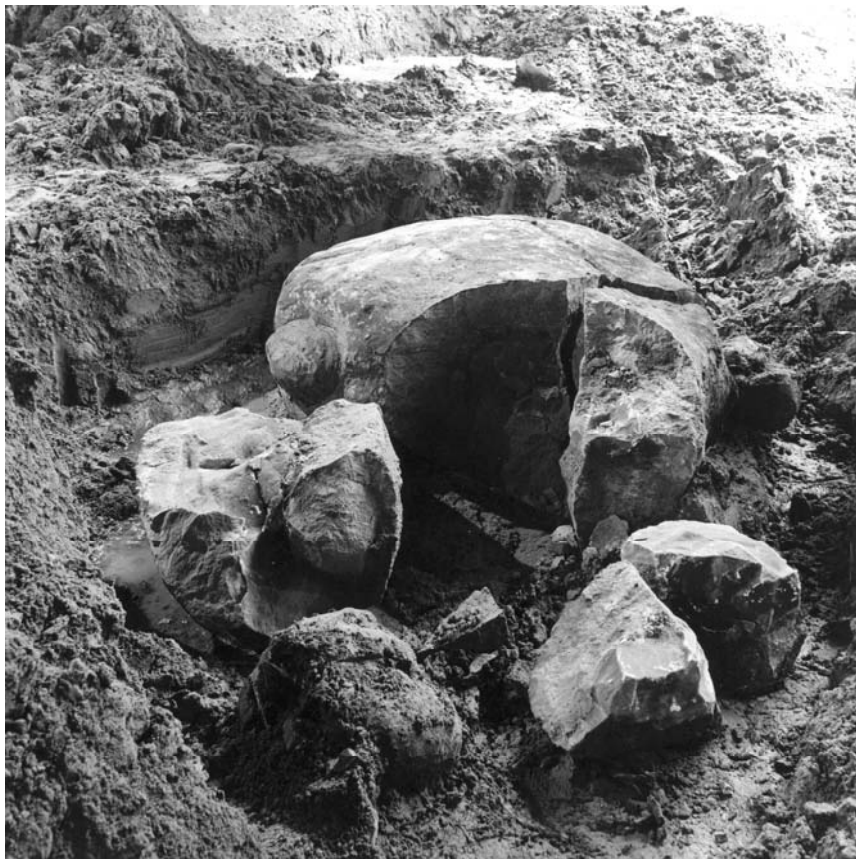
Foto 2. Rupeltunnel te Boom: door de werken gebroken kalkzandsteenconcreties in de bouwput.
