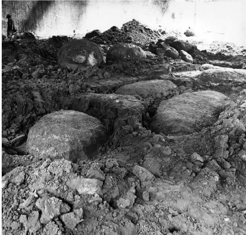
Foto 1. Rupeltunnel te Boom: kalkzandsteenconcreties in de bouwput; de figuur op de achtergrond geeft de schaal aan (foto Van Alboom, 1996).
