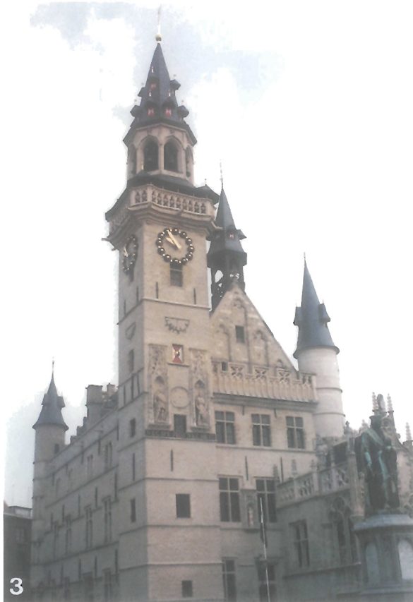
Foto 3 - Het Belfort van Aalst, gebouwd en gerestaureerd met zandstenen uit de Formatie van Lede. (Foto M. De Ceukelaire)
