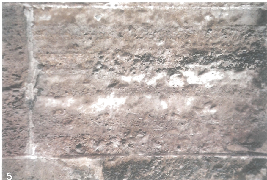
Foto 5 - Detail van de gebruikte zandsteen uit de Formatie van Lede in de St.-Martinuskerk te Lede. (Foto M. De Ceukelaire)
