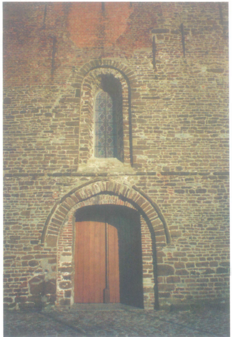
Foto 3 - Kerk van Opbrakel, gedeeltelijk opgetrokken uit zandstenen van de Formatie van Diest (30/6).
