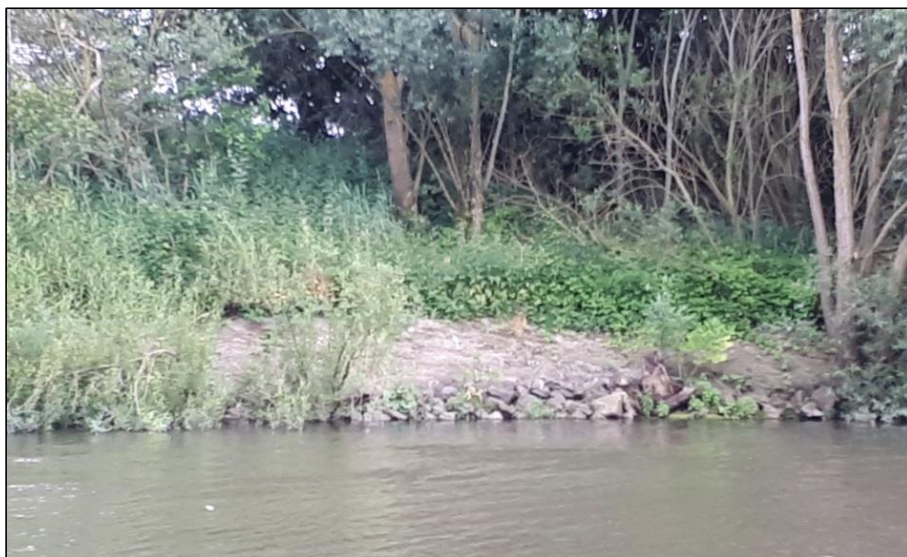
• De mesohabitat ‘asfaltmastiek’ bestaat uit breuksteen overdekt met asfaltmastiek. Door het aanbrengen van deze laag worden de schuilmogelijkheden sterk beperkt door het opvullen van de tussenruimten (Foto 7).
