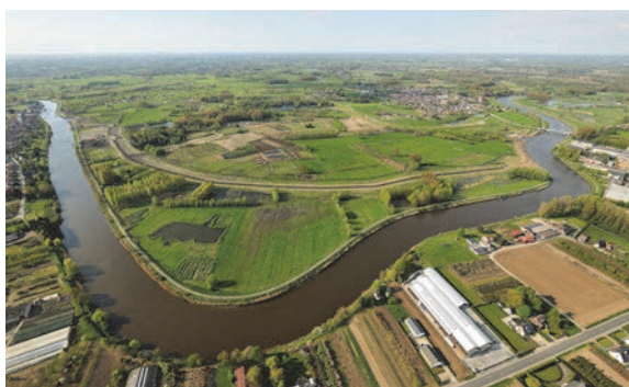
Figuur 13-1. Luchtfoto van Wijmeers ontpoldering. Situatie voorjaar 2015 (voor de uitvoering) (Vildaphoto – foto W&Z).
