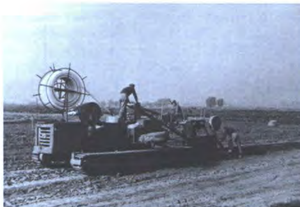
ILLUSTRATIE 12 Uitvoering van de ruilverkaveling. Om de agrarische productiviteit te verhogen, werden vochtige gronden met PVC-buizen gedraineerd. Voor de uitvoering van deze werken werd onder meer gebruik gemaakt van een sleuvengravende draineringsmachine (Bron: Fototheek VLM, Centrale Directie Brussel, Ruilverkaveling Vlamertinge, oktober 1969; 1 foto)
