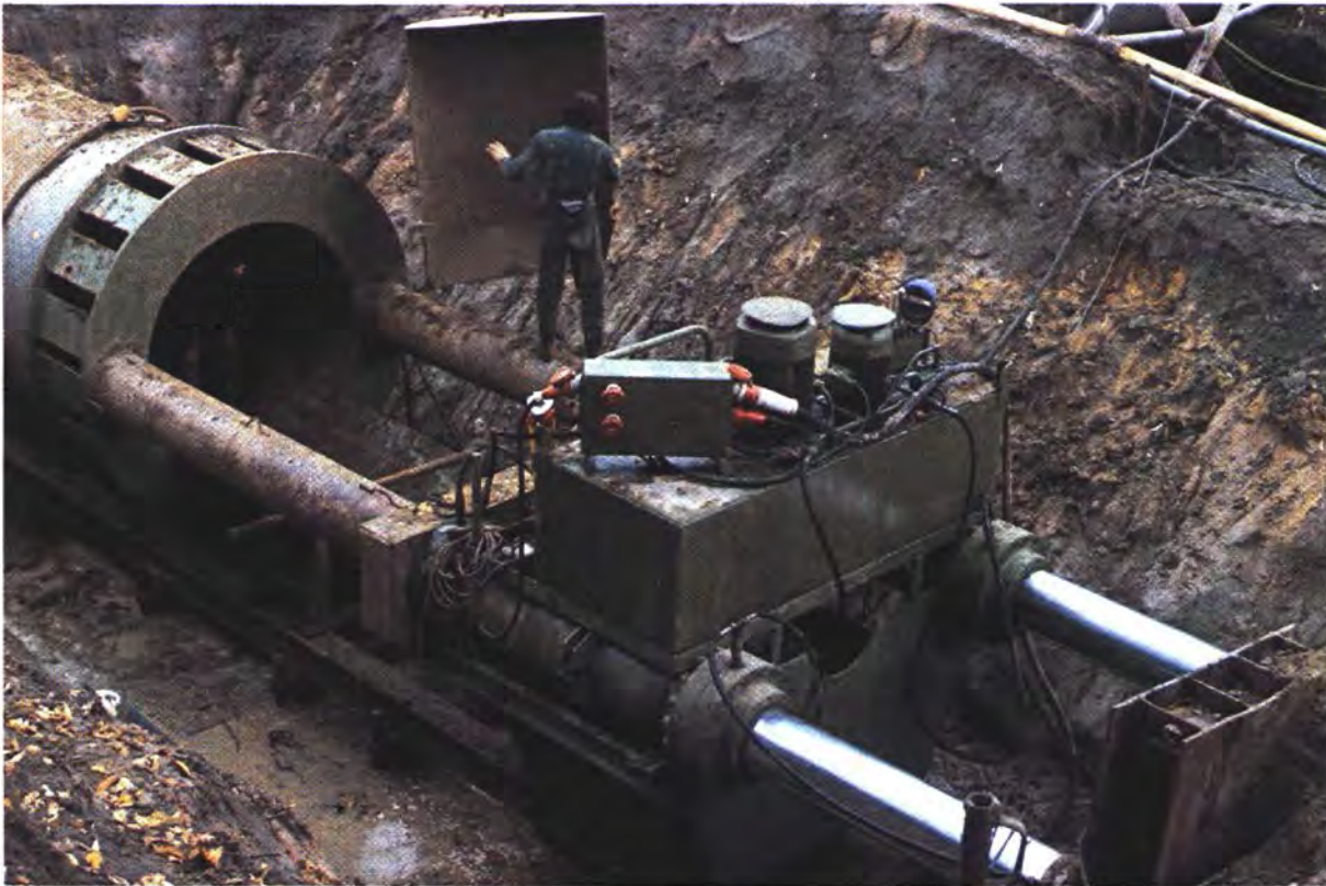
ILLUSTRATIE 25 Om de waterhuishouding ten behoeve van de landbouw te verbeteren, waren soms ingrijpende maatregelen nodig, zoals de aanleg van duikers. In Meerhout bijvoorbeeld liet het ruilverkavelingscomité een 80 meter lange duiker van 2 meter diameter aanleggen onder de rijksweg Meerhout-Kwaadmechelen (Bron: Landeigendom, 1987, p. 352, grote foto bovenaan)
