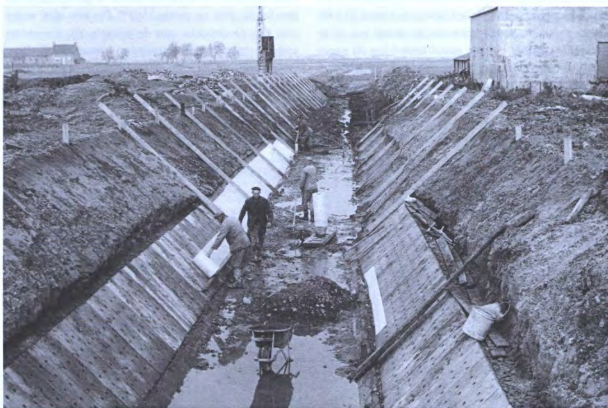
ILLUSTRATIE 13 Ten einde de gronden meer geschikt te maken voor landbouwexploitatie werden ingrijpende waterwerken uitgevoerd, vooral in de provincies Oost- en West-Vlaanderen. Bepaalde sloten werden rechtgetrokken, verbreed of gedempt en nieuwe afwateringsgrachten werden gegraven (Bron: Fototheek VLM, Centrale Directie Brussel, Ruilverkavelingen Vlamertinge en Wilskerke, oktober 1966; 3 foto's)
