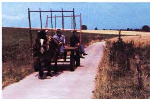
ILLUSTRATIE 29 Voor de ontsluiting van de landbouwgronden werden moeilijk berijdbare, aarden wegen verhard. In de Limburgse leemstreek kregen tal van holle wegen een betonnen verharding (Bron: Landeigendom, 1980, p. 208; foto 1 en 3).
