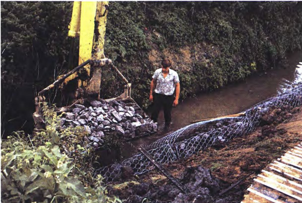
ILLUSTRATIE 26 Ten einde beekerosie te voorkomen, werden kunstmatige oeverversterkingen aangebracht. Een veel gebruikte techniek was om de oevers te versterken met schanskorven. Deze techniek werd onder meer toegepast in de Vlaams-Brabantse ruilverkaveling Ternat (Bron: Landeigendom, 1988, p. 101)
