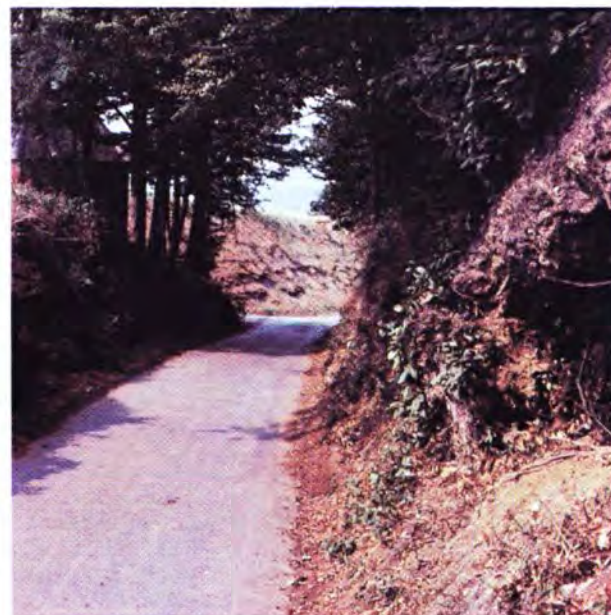
ILLUSTRATIE 29 Voor de ontsluiting van de landbouwgronden werden moeilijk berijdbare, aarden wegen verhard. In de Limburgse leemstreek kregen tal van holle wegen een betonnen verharding (Bron: Landeigendom, 1980, p. 208; foto 1 en 3).
