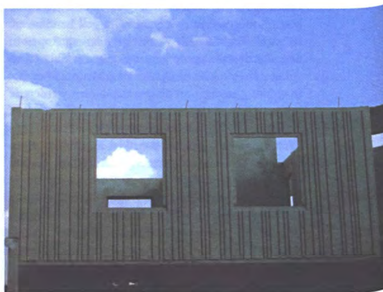
ILLUSTRATIE 20 Puurs in de provincie Antwerpen (1980). Bij de prefabricatie van sociale woningen werden grote stukken van de ruwbouw kant en klaar aangeleverd (Bron: Jaarverslag NLM 1980, 4 foto's)
