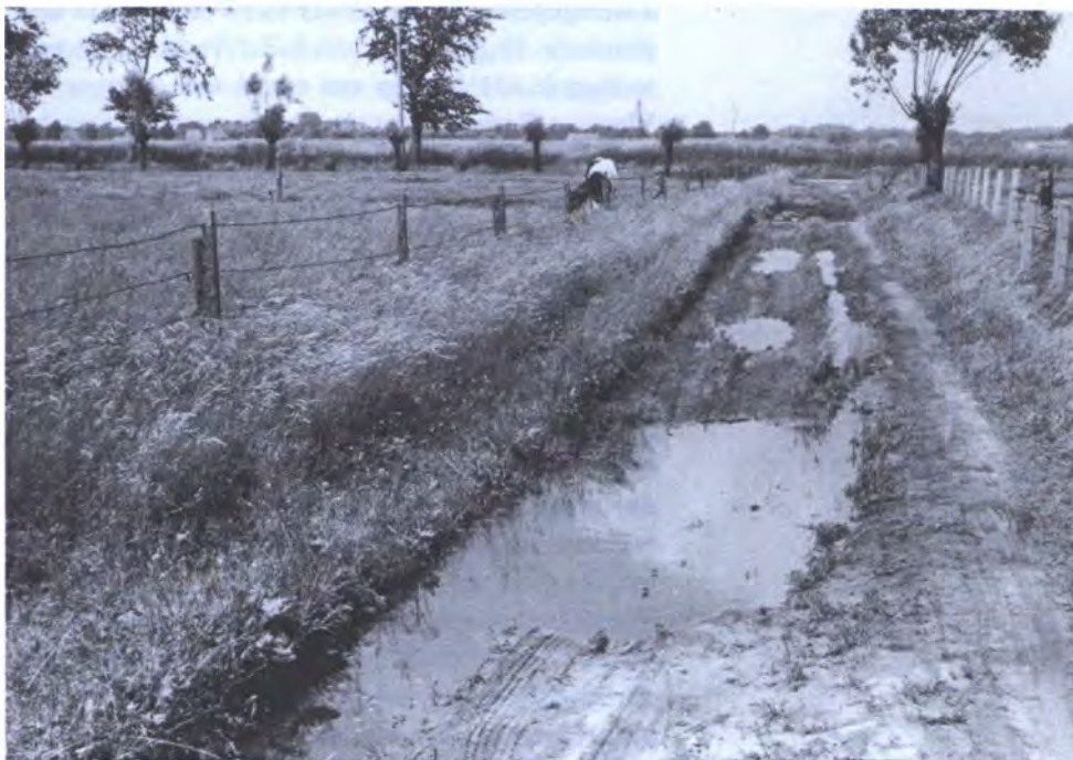
ILLUSTRATIE 14 Om de toegang tot de percelen te verbeteren, werden tal van veldwegen verhard met beton of asfalt. Sinds de tweede helft van de jaren 1960 werden de betonwegen voorzien van krimpvoegen (Bron: Fototheek VLM, Centrale Directie Brussel, 1967; 3 foto's).
