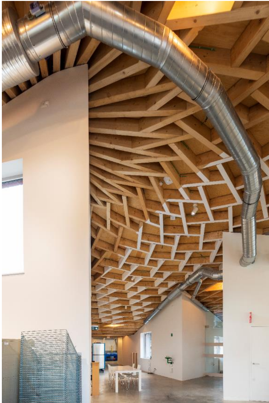
Interieur nieuwbouw - kunstintegratie plafond Jean Glibert © Team Infrastructuur & Instellingen
