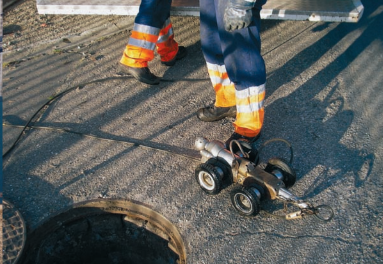
MI voerde een inspectie uit van het rioleringsnet met behulp van een rioolcamera
