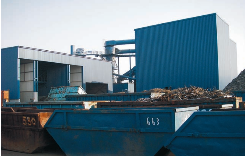
MI liet emissiemetingen uitvoeren op de schouw van deze shredderinstallatie
