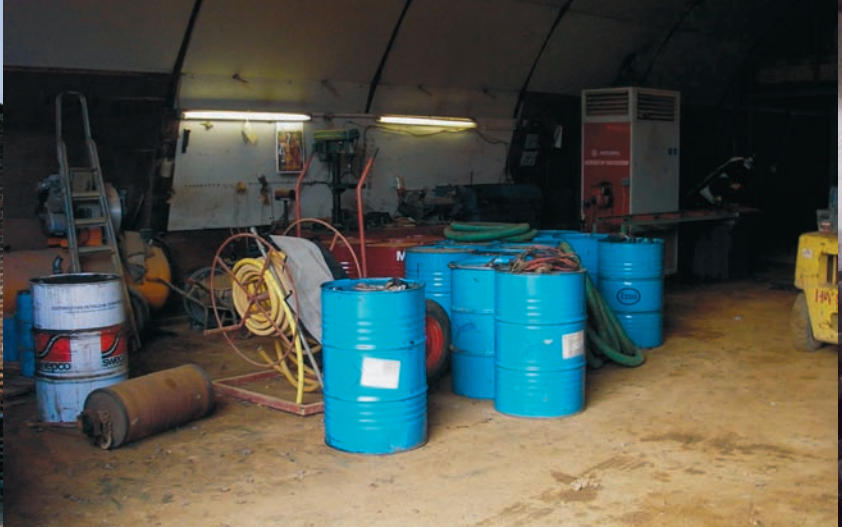
De meest voorkomende tekortkomingen waren het niet naleven van de preventieve maatregelen ter bescherming van de bodem en het ontbreken van een oriënterend bodemonderzoek
