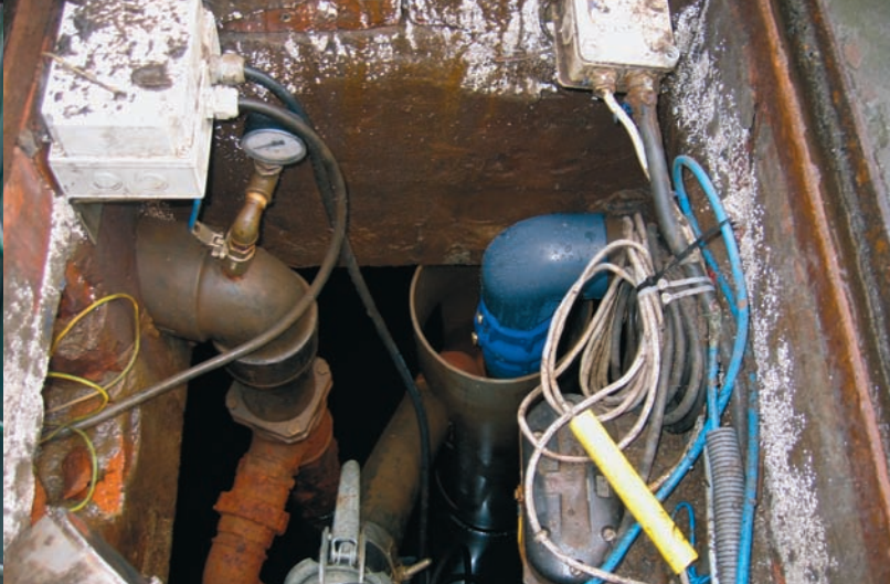
MI stelde onder andere vast dat de debietmeters van de diepe boorputten terugliepen
