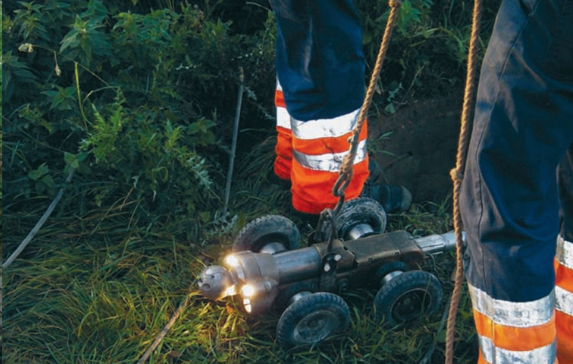
MI laat camera-inspecties uitvoeren van riolen en leidingen om na te gaan of er geen onbekende aansluitingen zijn
