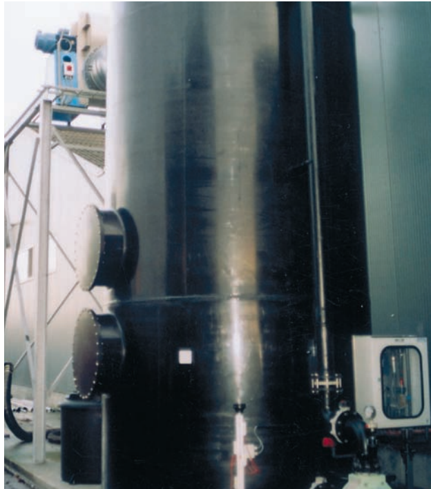
De afgezogen lucht wordt sinds november 2006 behandeld in deze luchtwater
