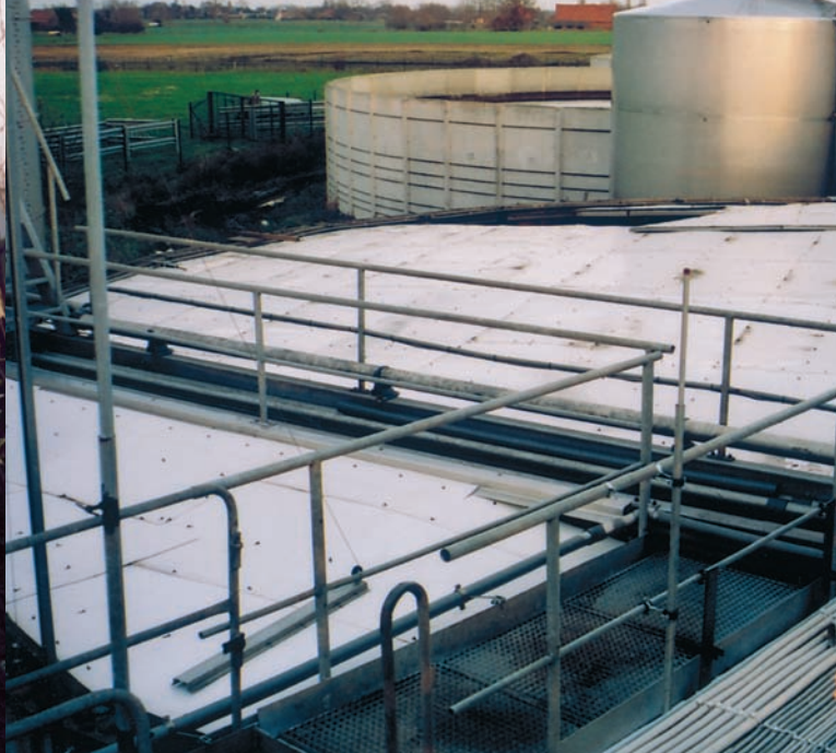
De geuroverlast verminderde door de overkapping van de bufferbekkens van de waterzuivering
