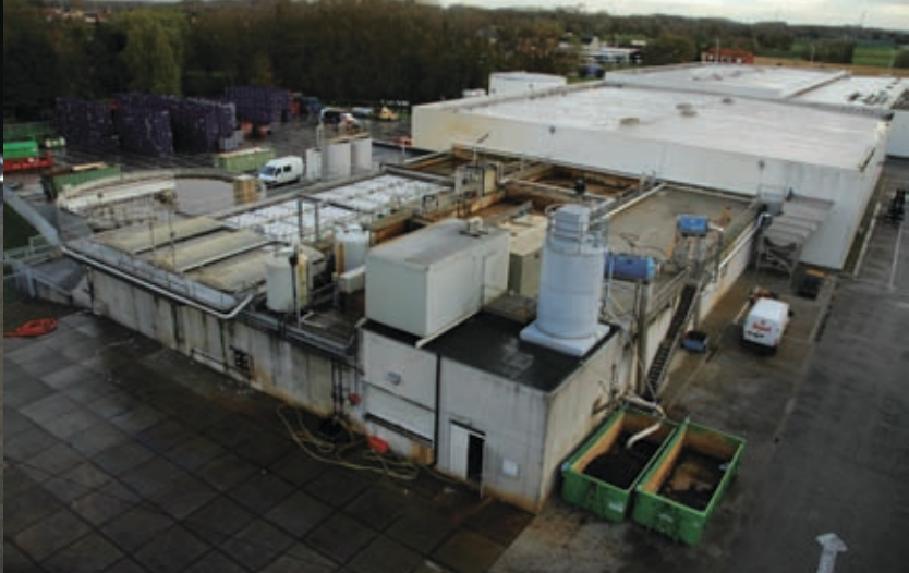
Na de veranderingswerken aan de waterzuivering voldeed de brouwerij aan de opgelegde lozingsnormen
