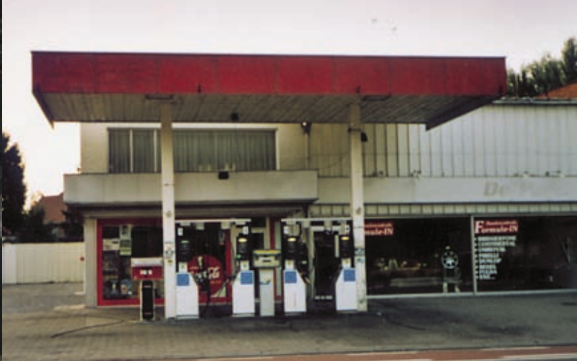
MI stelde vast dat dit benzinestation geen vergunning had en niet voldeed aan diverse voorwaarden
