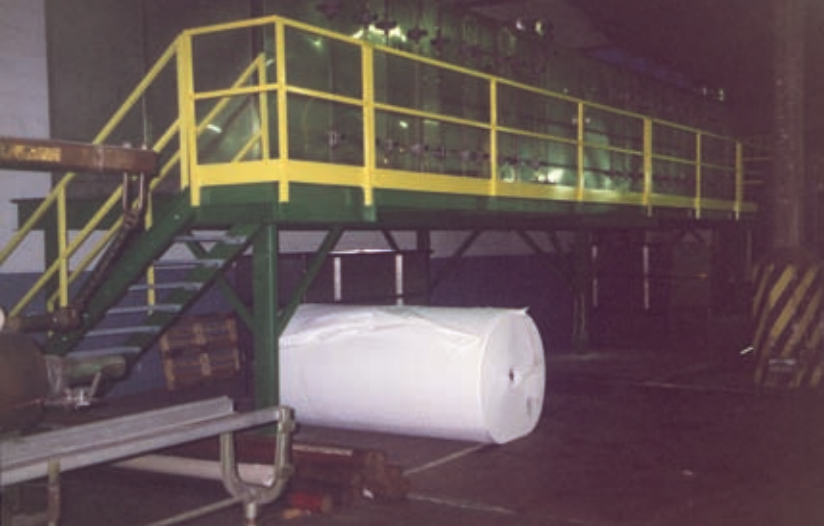
Het bedrijf plaatste een installatie voor het zuiveren van de afgassen zodat de emissiegrenswaarde voor formaldehyde niet meer werd overschreden
