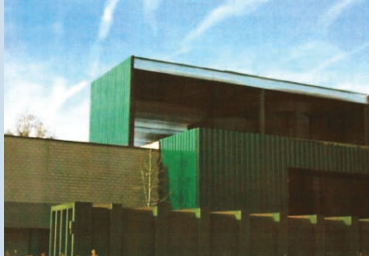
Begin 2006 stelde MI vast dat met de plaatsing van een gebouw rond de onderdelen van de afzuiginstallatie voldaan was aan de saneringseis uit de milieuvergunning
