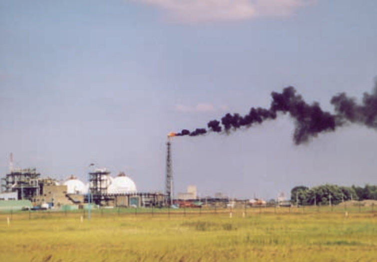
MI liet een veiligheidsonderzoek uitvoeren bij een petrochemisch bedrijf waarbij de installaties herhaaldelijk uitvielen met hevige fakkelwerking tot gevolg
