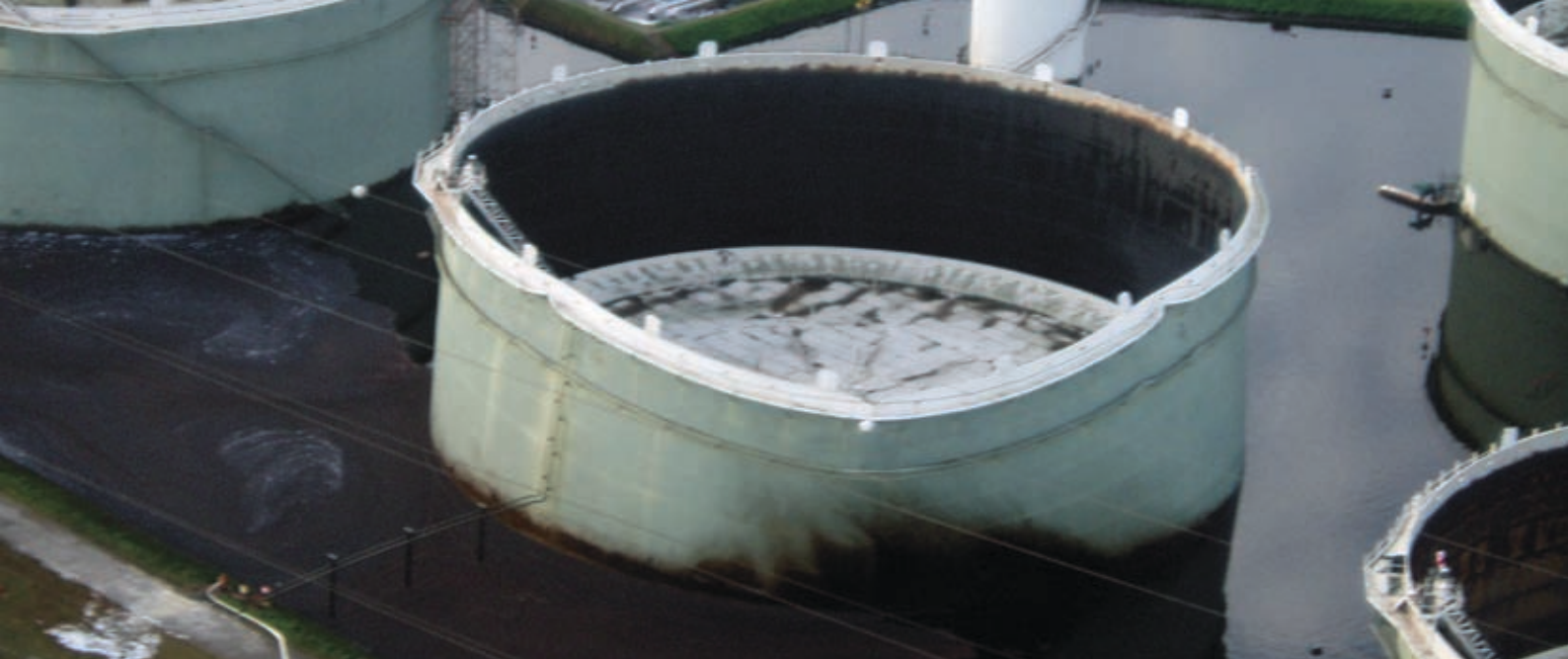
De aarden inkuiping rond de gescheurde tank was tot ongeveer één meter hoog gevuld met aardolie
