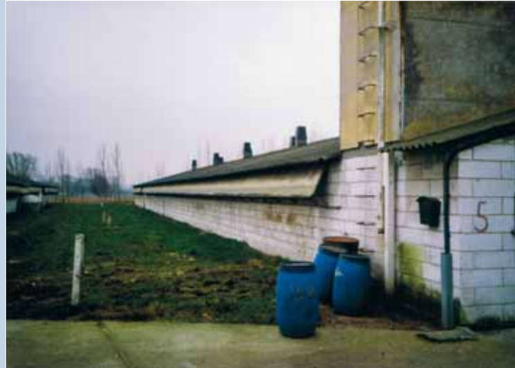
De geurhinder van deze kippenstal leidde tot een veroordeling door de Correctiebank.
