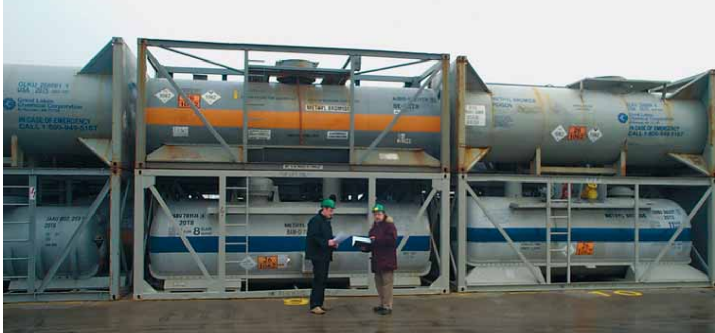
MI inspecteert de opslag van methylbromide in een bedrijf.
