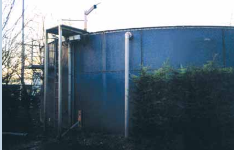
Terwijl de exploitant de waterzuivering saneerde, bracht MI geregeld het parket op de hoogte van de evolutie.
