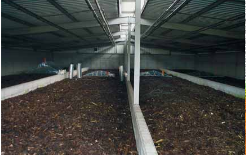
Overdekte biofilter bij de GFT-composteringsinstallatie in Ieper
