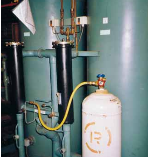
De exploitant en zijn koeltechnicus hebben het zich gemakkelijk gemaakt om koelgas bij te vullen...
