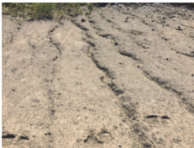
Figuur 44. De sulfaatlus langs de Scheldelaan, A'pen RO: vegetatie maakt geen kans op deze dijk van pyriethoudende Boomse klei. Zonder vegetatie tast geul-erosie het dijklichaam aan.
