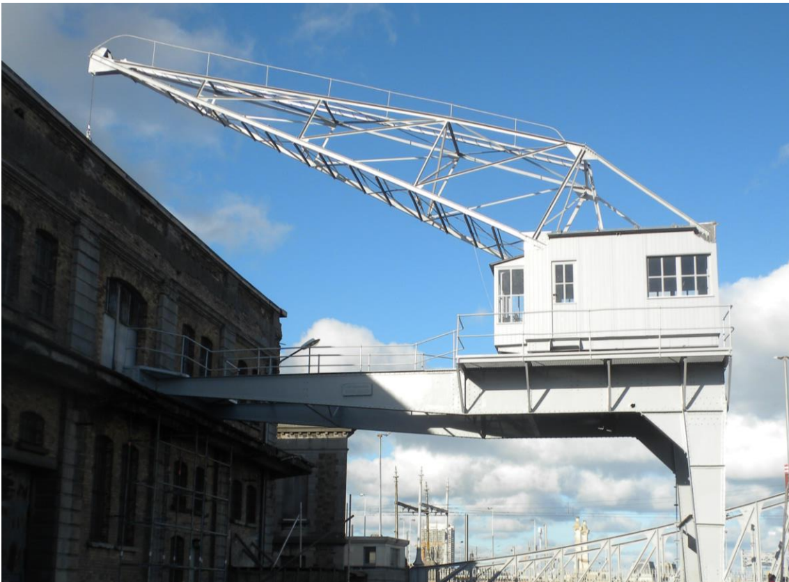
De halfportkraan in Oostende voor (boven) en na (onder) herstel.
