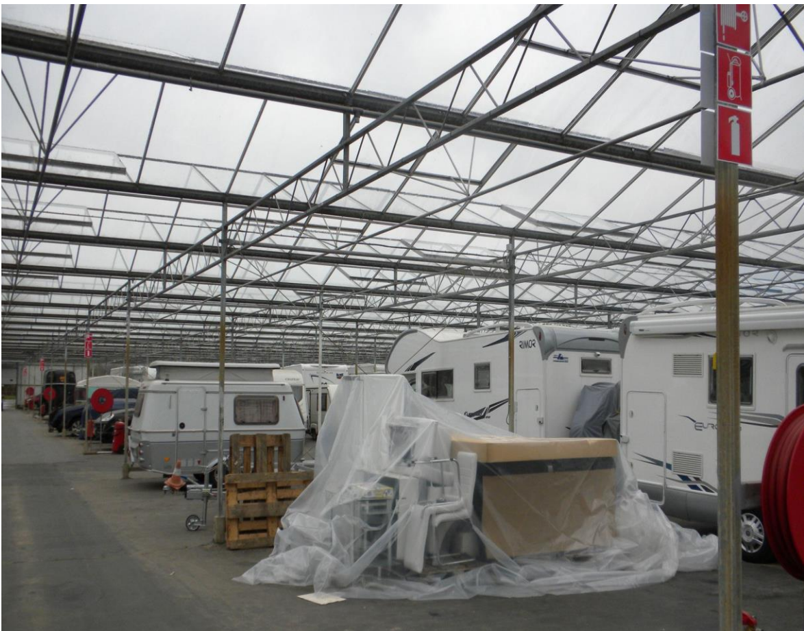
Schending die bestaat uit het gebruik van een serre als stalplaats voor voer- en vaartuigen.
