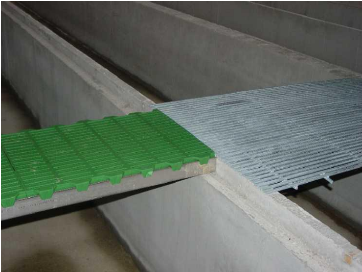
Figuur 12 AEA-systeem voor biggen V-1.5, links groene kunststofrooster boven waterkanaal, rechts metalen driekantrooster boven mestkanaal
