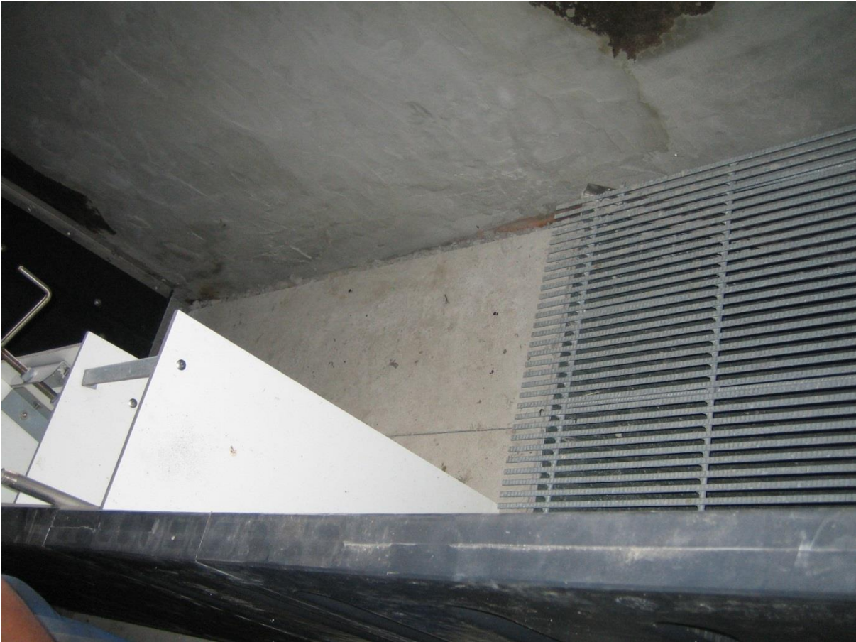
Figuur 16 AEA-systeem voor biggen V-1.6, in een uitvoering zonder waterkanaal
