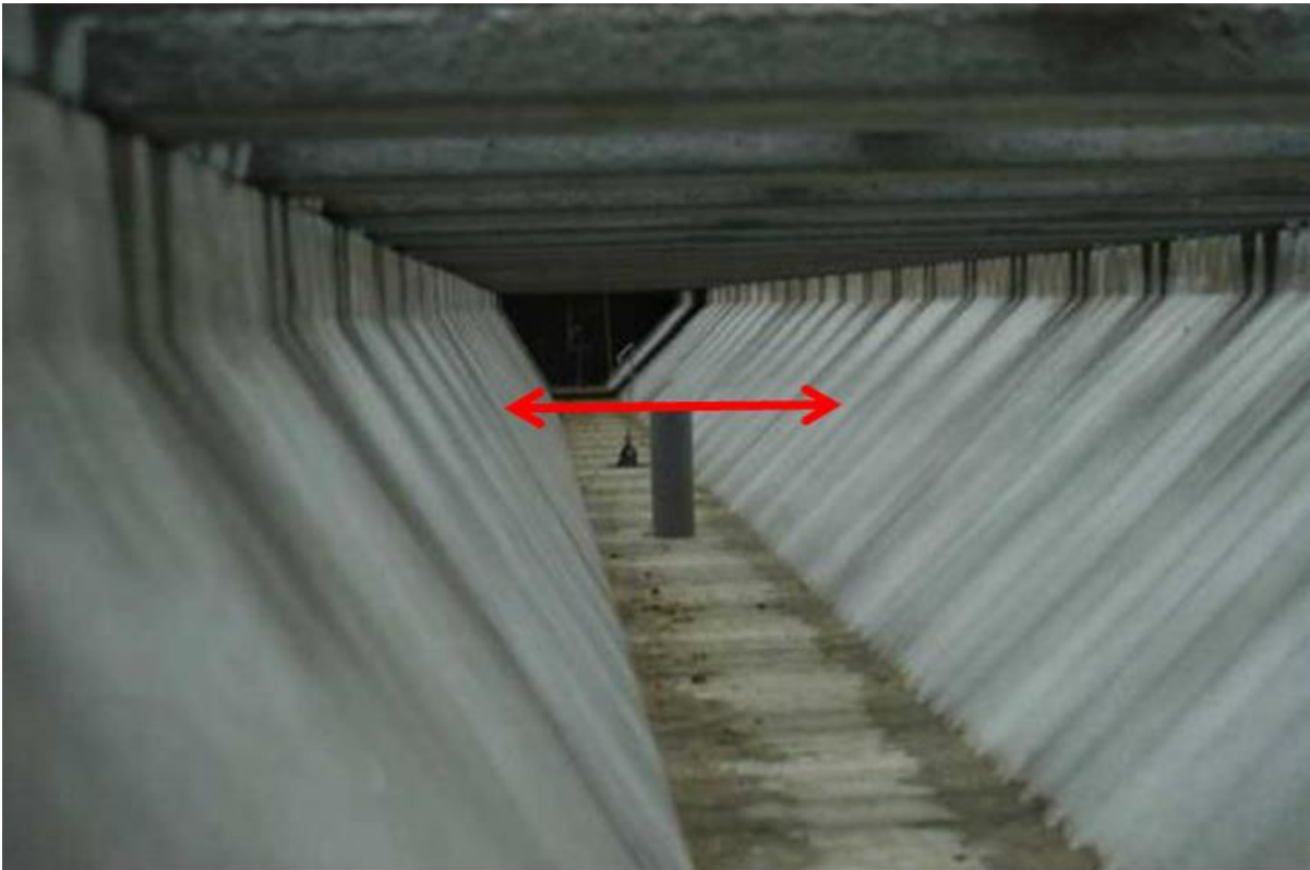
Figuur 3 Prefab mestkanaal met schuine wanden, voorzien van een overloop (voorgrond) en een afluatsysteem (achteraan)
