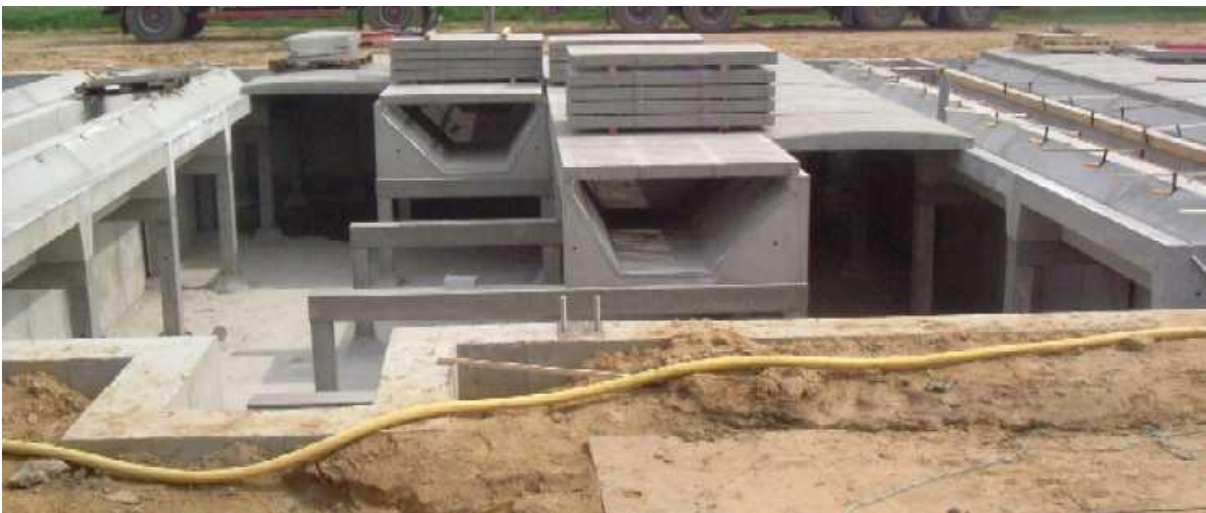
Figuur 25 Mestgoten, waterkanaalgoten en bolle vloeren
