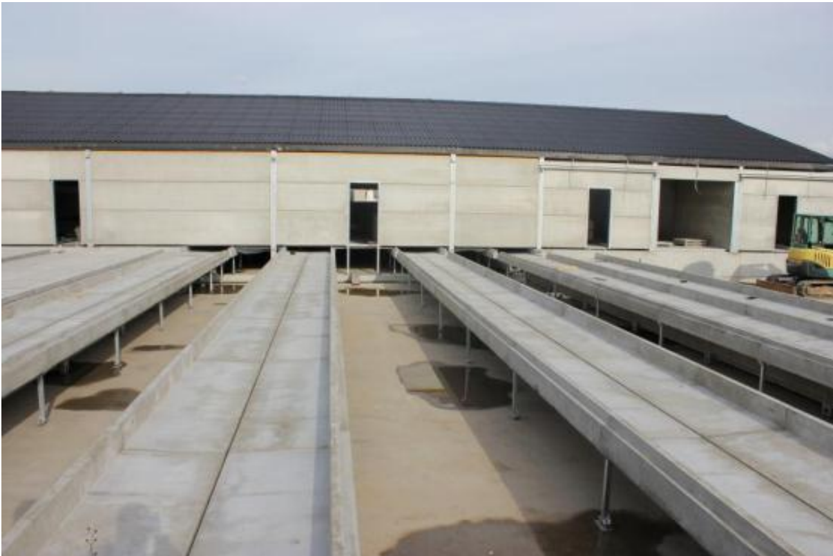
Figuur 32 V-4.8 in opbouw: gecombineerde mest- en giergoten zijn al geplaatst, de mest zal worden geschraapt naar een mestband achteraan
