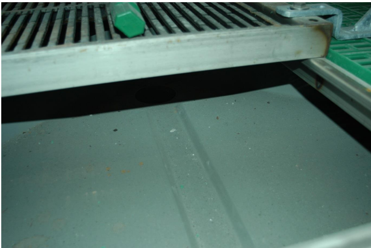
Figuur 58 V-2.6, mestpan onder kraamhok
