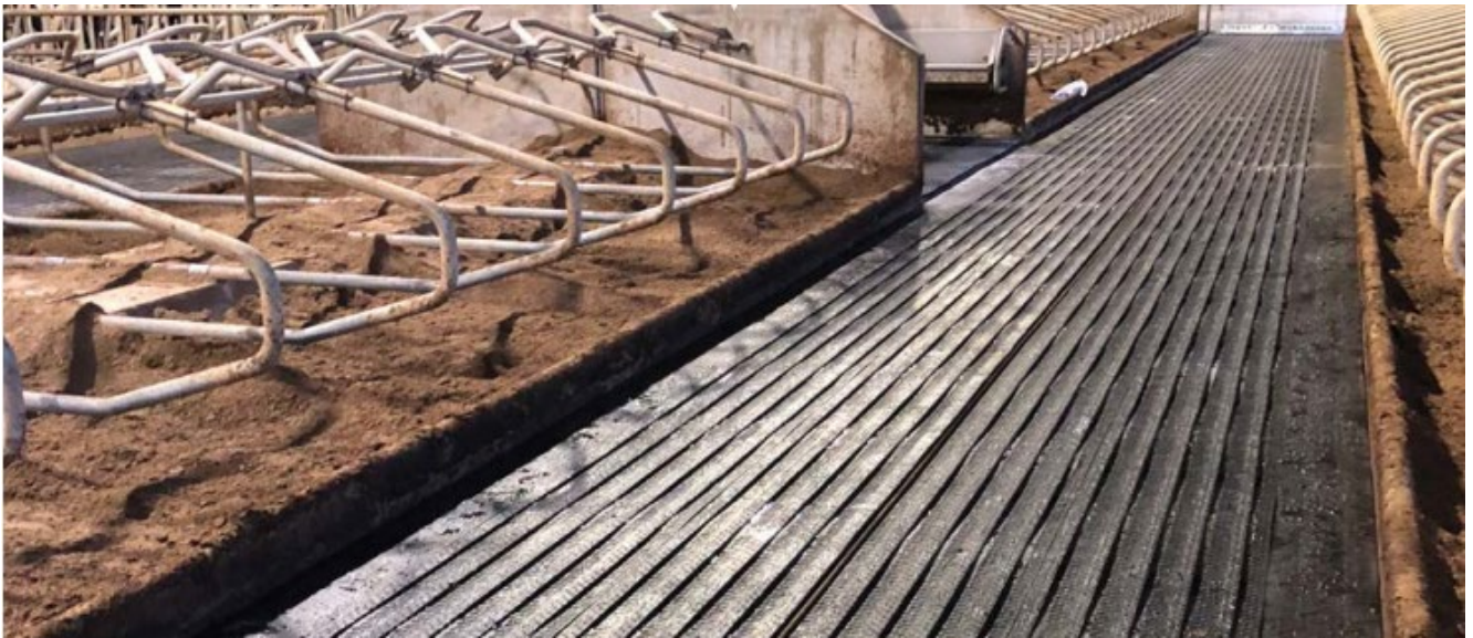
Figuur 33: Rubbermatten voorzien van sleuven en geprofileerde balken met hellend profiel (bron: V17 Agro BV)
