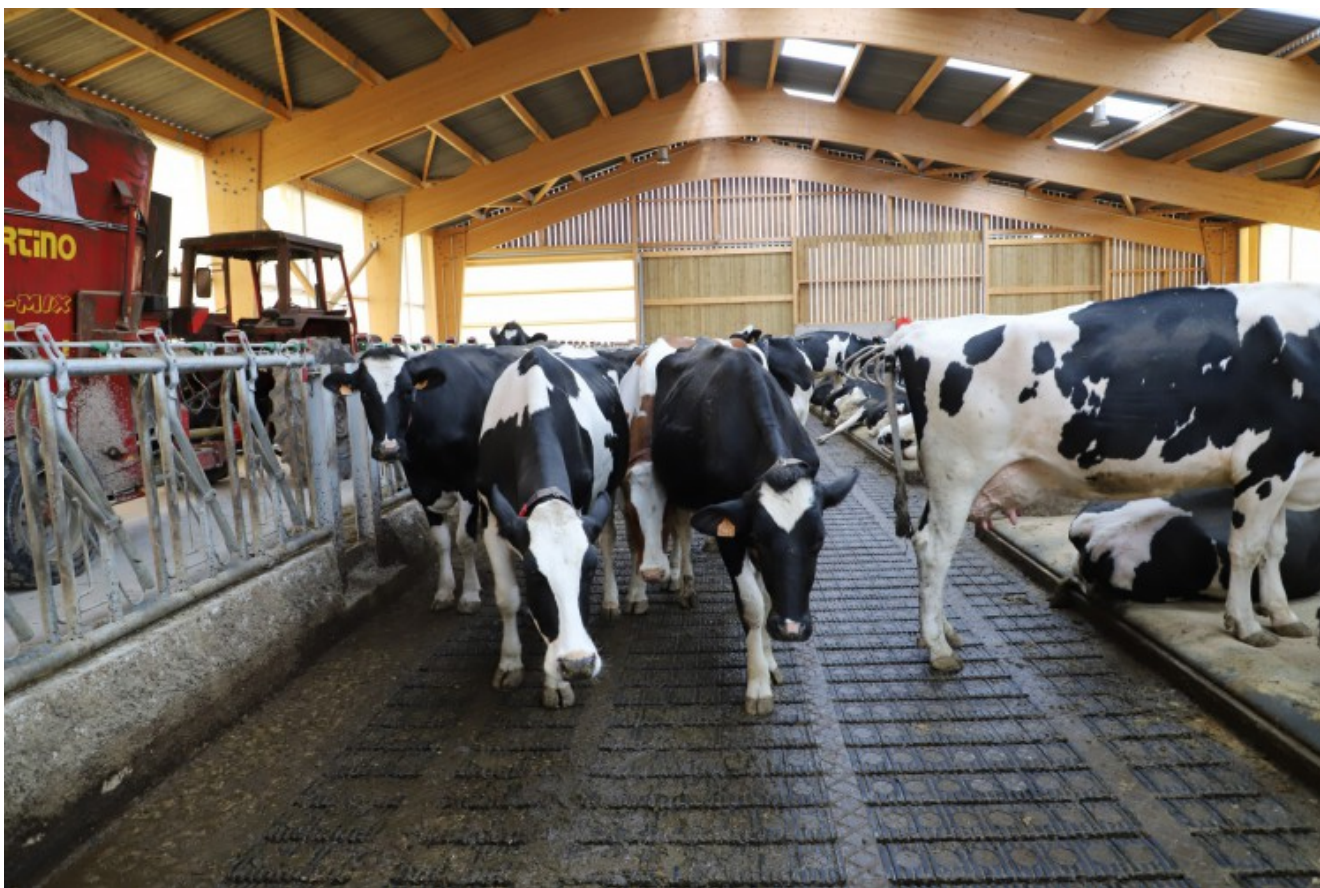
Figuur 32: Roostervloer met rubberen elementen (Bron: Cobefa)
