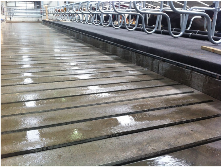
Figuur 23: Roosterelement in helling geplaatst en sproei-installatie in de boxrand (bron: Swaans Beton)
