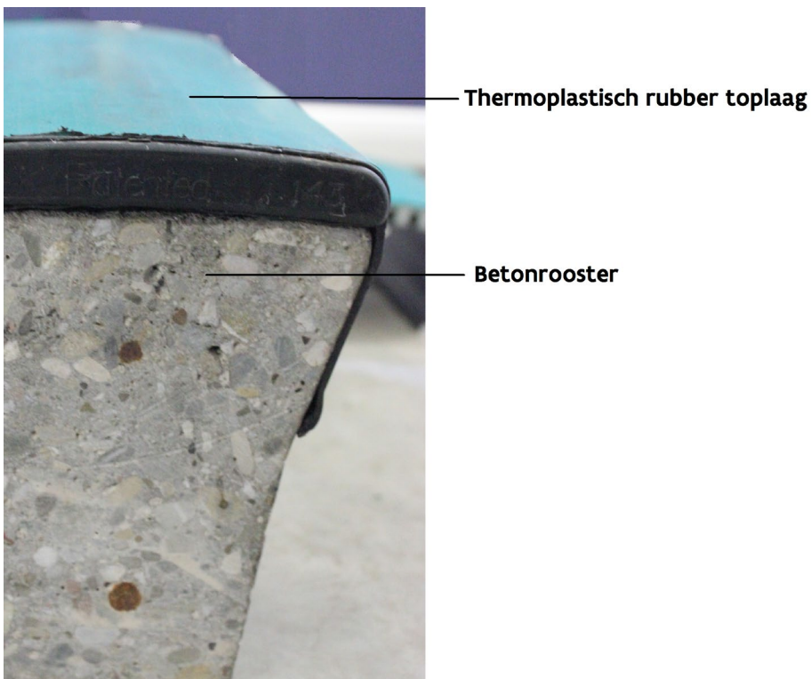
Figuur 16: Dwarsdoorsnede van rooster met thermoplastische rubber toplaag
