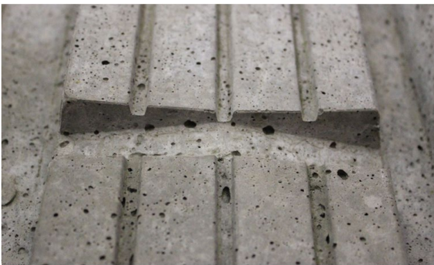
Figuur 12: Detail dwarsgroef
