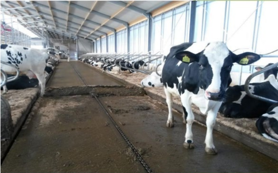
Figuur 27: Hellende vloer met twee giergoten aan de zijkant en mestschuif (bron: Berkelbeton)
