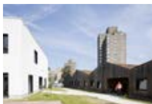
OO 1314 Project GO Neder-Over-Heembeek Plaats Koning Albertlaan 181, 1120 Neder-over-Heembeek Programma BuSo, MPI en opvangcentrum Bouwheer Gemeenschapsonderwijs Ontwerp B-architecten Bouwjaar 2017
