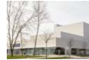
OO 2202 Project Cultuurcentrum Deinze Plaats Brielstraat – Mouterijdreef 9800 Deinze Programma Cultuurcentrum Bouwheer Stadsbestuur Deinze Ontwerp V+, Trans Bouwjaar 2019
