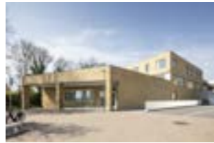
OO 1820 Project Administratief centrum Bierbeek Plaats Speelpleinstraat 10, 3360 Bierbeek Programma Administratief centrum Bouwheer Gemeentebestuur Bierbeek Ontwerp 360 architecten Bouwjaar 2016
