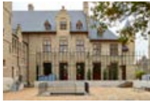
OO 1816 Project Stadhuis Diksmuide Plaats Grote Markt 6, 8600 Diksmuide Programma Administratief centrum Bouwheer Stadsbestuur Diksmuide Ontwerp ONO Bouwjaar 2016
