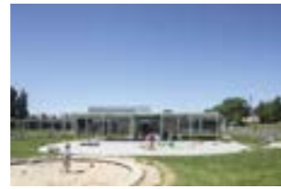
OO 2007 Project Scholencampus Knokke Plaats Kragendijk 182, 8300 Knokke-Heist Programma Basis- school Bouwheer Gemeentebestuur Knokke-Heist Ontwerp NL architects Bouwjaar 2016
