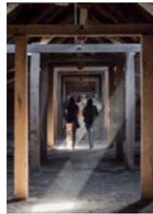
De leegstaande noordvleugel van de hoeve van Wortel-Kolonie. © Tim Van de Velde
