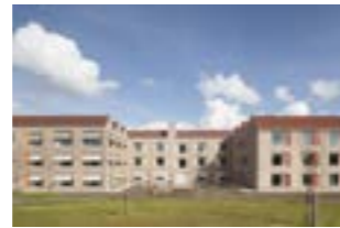
OO 2103 Project Zorgcampus Wingene Plaats H. Sacramentstraat, 8750 Wingene Programma Woon- en zorgcentrum, centrum voor dagverblijf, assistentiewoningen, dagverzorgingscentrum en dienstencentrum Bouwheer vzw Amphora Ontwerp Sergison Bates architects Bouwjaar 2016
