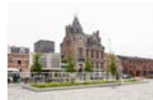
OO 1910 Project Publieke ruimte Wijnegem Plaats Centrum, 2110 Wijnegem Programma Publieke ruimte Bouwheer Gemeentebestuur Wijnegem Ontwerp Brut, Land landschapsarchitecten Bouwjaar 2018
