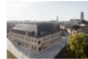
OO 2213 Project Bibliotheek Predikheren- klooster Mechelen Plaats Predik- herenklooster, Edgard Tinellaan en Goswin de Stassartstraat, 2800 Mechelen Programma Bibliotheek Bouwheer Stadsbestuur Mechelen Ontwerp Korteknie Stuhlmacher architecten Bouwjaar 2019
