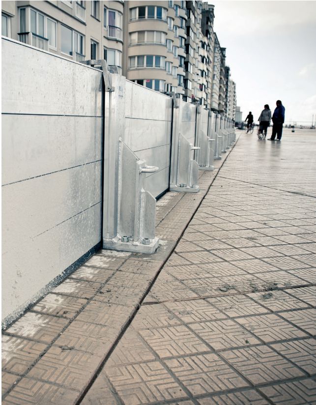
Voorbeeld van de mobiele kering in gesloten toestand
