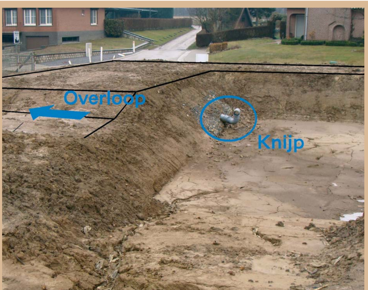
Foto 4: Een overloopzone, gescheiden van de knijpopening.
