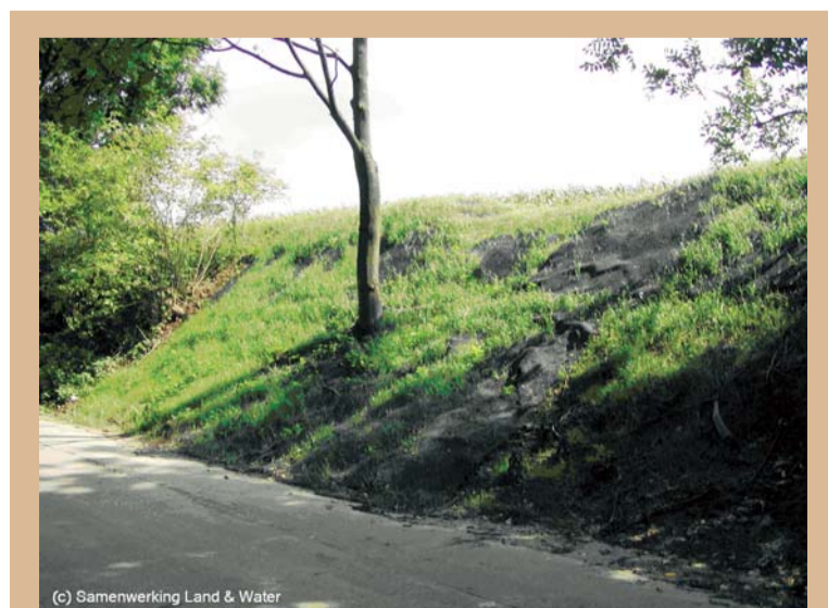
Foto 1: Talud met erosiemat.
