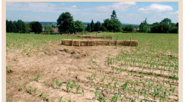
Figuur 3: De dammen van strobalen worden in serie geplaatst op de stroombaan van het water.
