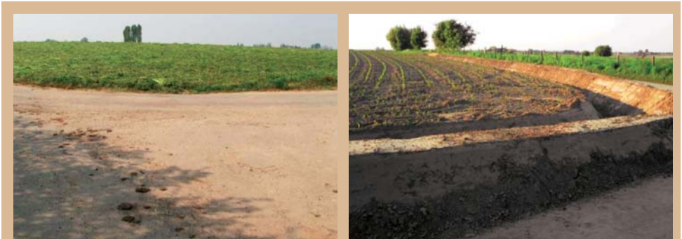
Foto 2a en 2b: De aanleg van een aarden dam met erosiepoel moet ervoor zorgen dat het water stroomopwaarts de Franse Beek wordt gebufferd.
