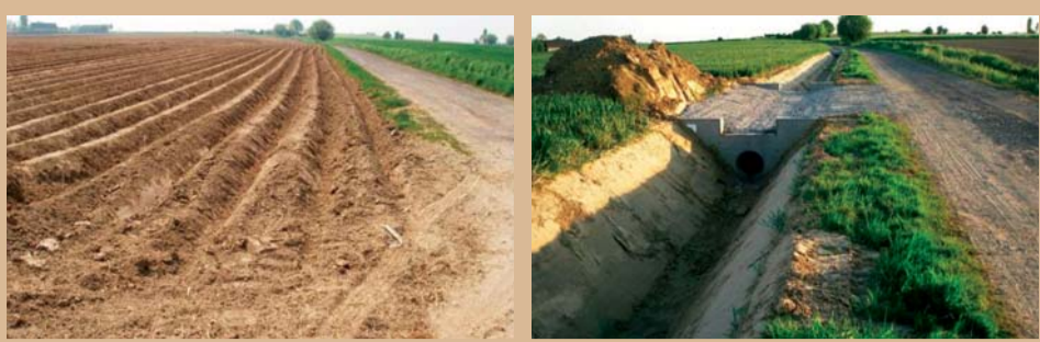
Foto 3a en 3b: Bij hevige regenval verzamelt zich een omvangrijke hoeveelheid oppervlaktewater in de Vandrommedreef, die afwatert richting de dorpskom van Westouter. Een bufferende gracht langs de Vandrommedreef moet mee instaan om deze problematiek te verhelpen.
