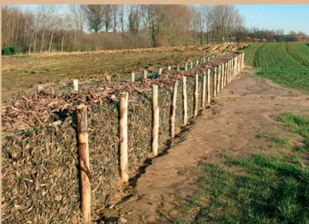
Figuur 6. Opvang van sediment aan een houthakseldam.
