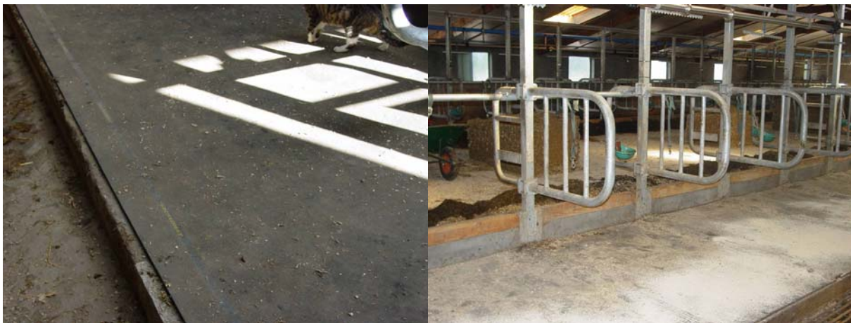
Figuur 30 Mat op rol (links) en individuele matten (rechts), voorzien van een verbindingstuk
