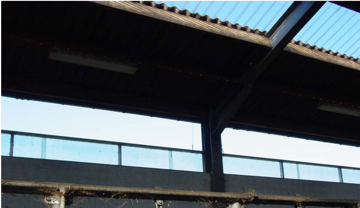
Figuur 35 Regelbare doorlaatopening
