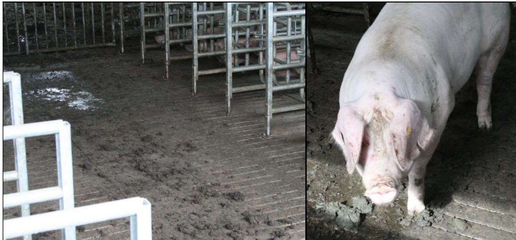
Figuur 23 Bevuilde roosters in loopgang
