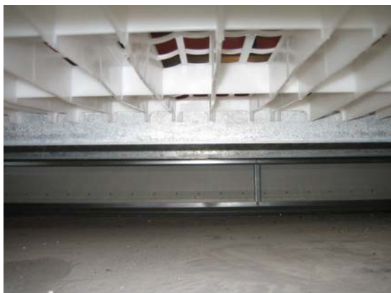
Figuur 20 Mestband met beluchting onder rooster
