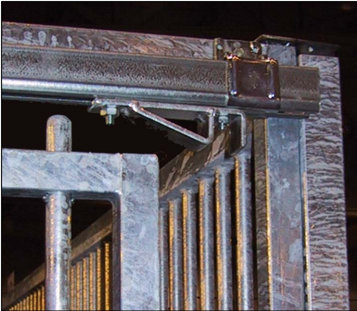
Figuur 33 Grendelsysteem voor schuifdeuren
