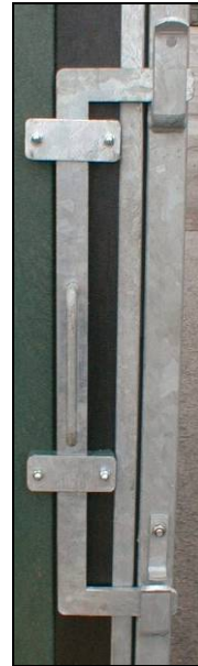
Figuur 34 Grendelsysteem voor scharnierende deuren
