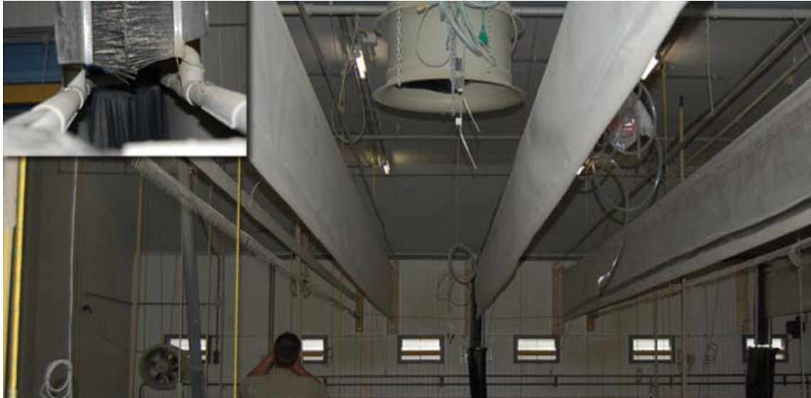
Figuur 2 Ionisatie, de kunststof platen vangen het stof dat via de borstels met opvangzak wordt verzameld (Bron: Agrilife)
