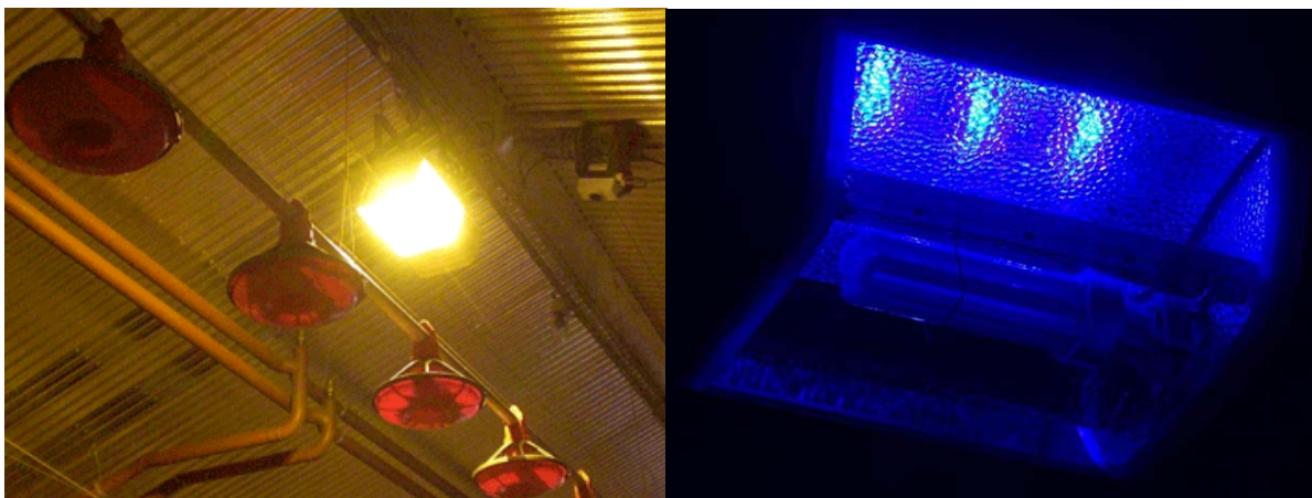
Figuur 26 Types lampen: links hoge druk Natriumlamp en rechts PL-lamp (soort TL-lamp) met blauwe LEDs (Bron: Boerderij)
