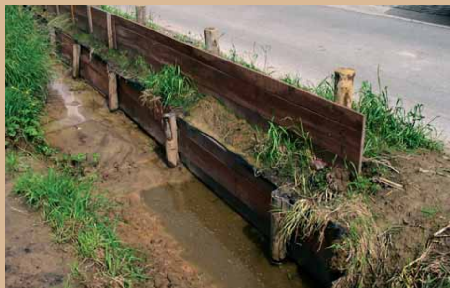
Foto 3 (onder): Afzetting van sediment ter hoogte van de dwarswand op de baangracht.
