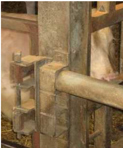
Figuur 64. Horizontale buis vóór de palen geplaatst
