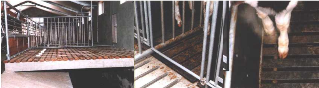
Figuur 51. Van links naar rechts: hardhouten roosters, betonroosters met een rubber toplaag, kunststof roosters Bron: Wolff
