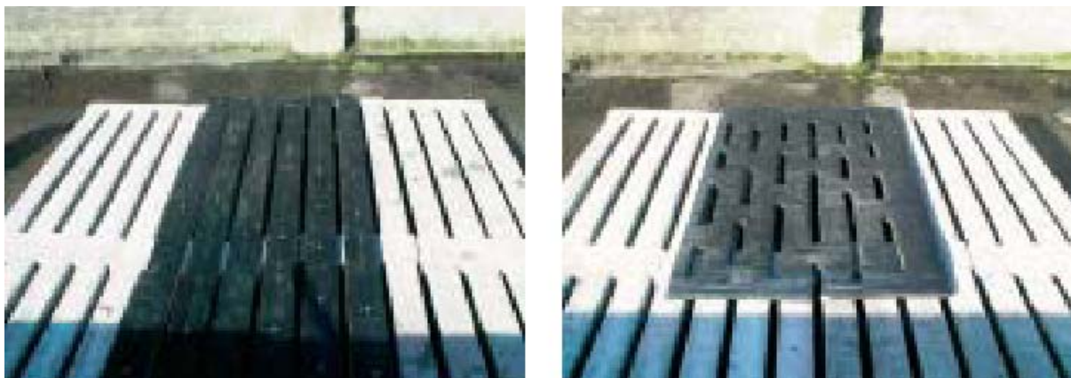
Figuur 33. Betonroosters met rubber strippen (links) en met geperforeerde rubber matten (rechts) Bron: AgriSearch
