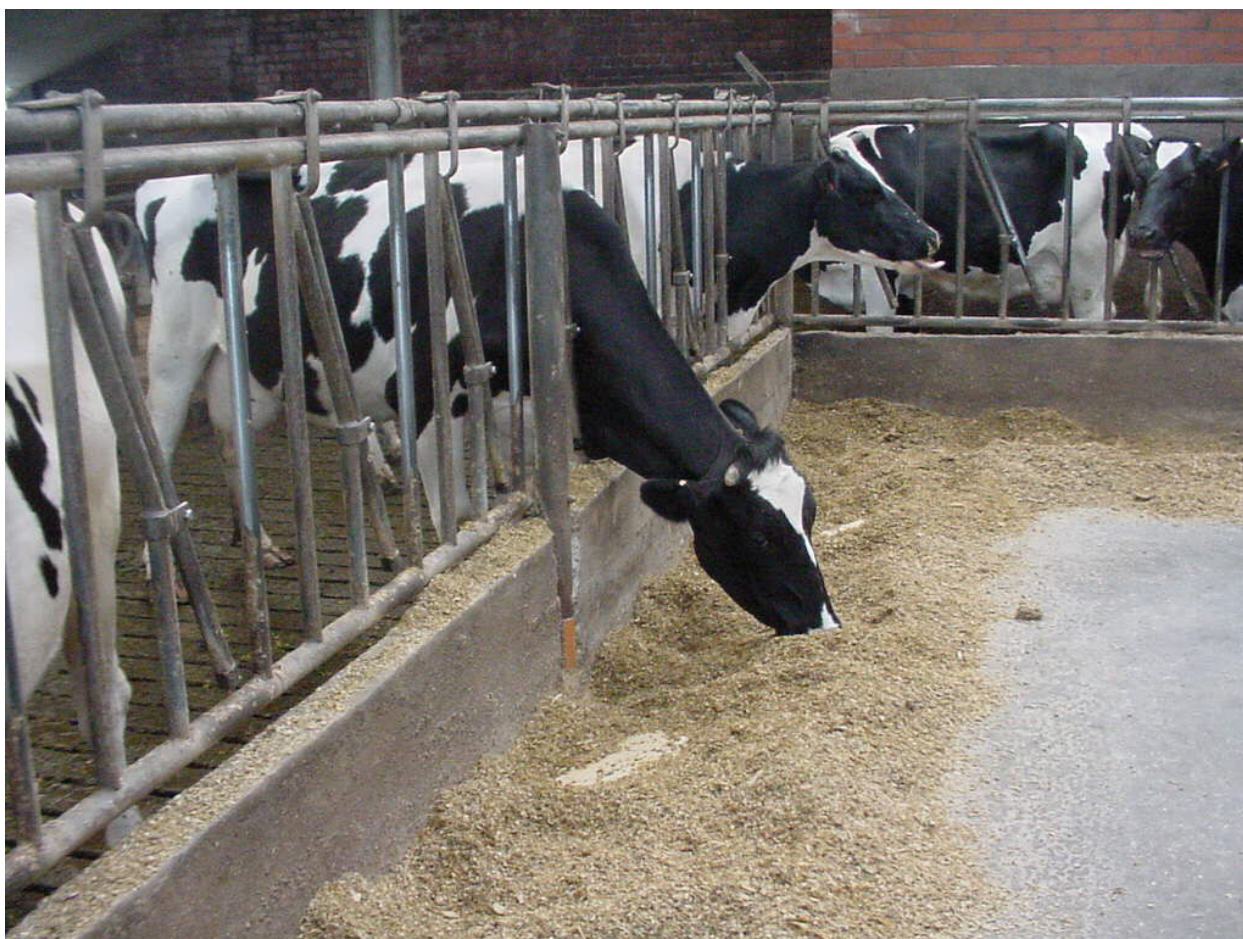
Figuur 15 De bovenbuis van het voederhek en het oppervlak van de voedergoot moeten de voederopname stimuleren
