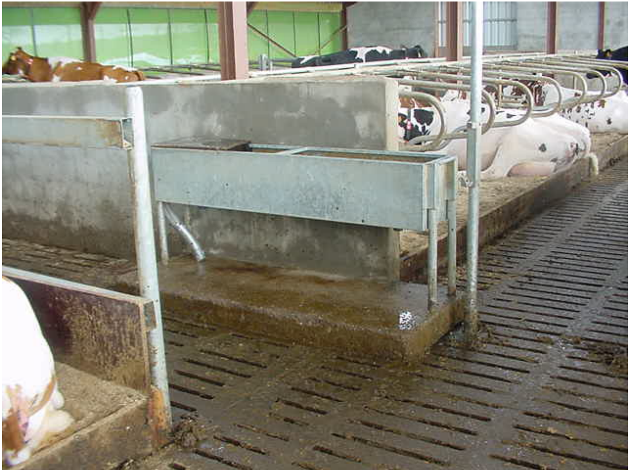
Figuur 16 Drinkbakken moeten gemakkelijk schoon te maken zijn en zo geplaatst worden dat minstens 2 koeien tegelijk kunnen drinken
