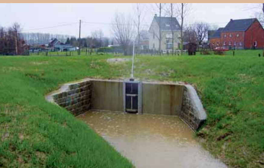
Erosiepoel met regelbare schuif waarmee het uitstroomdebiet kan aangepast worden.
