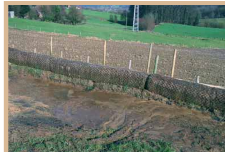
Dam uit kokosbalken (Lamontstraat).
