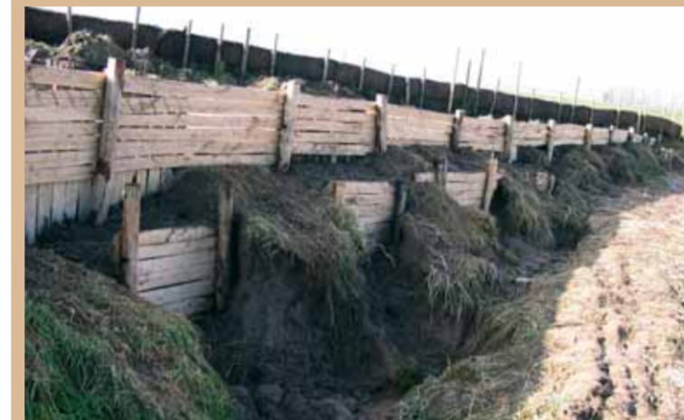
Bermversterking met palenrijen, planken en jutematten (Lamontstraat).
