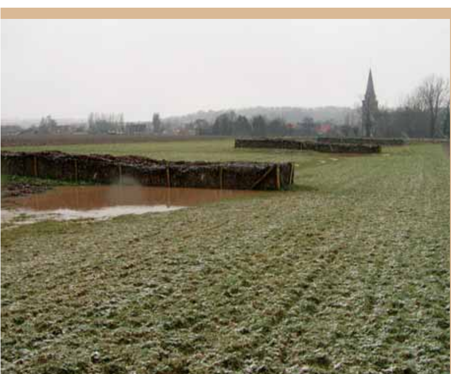
Dam uit snoeiafval in werking (Kattesteeg te Gingelom).
