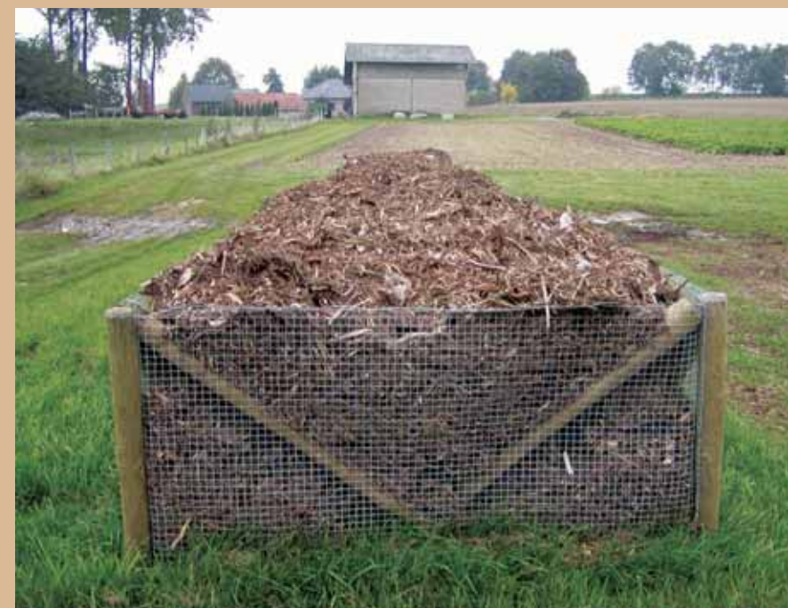
Detail van dam uit snoeiafval (Kattesteeg te Gingelom).
