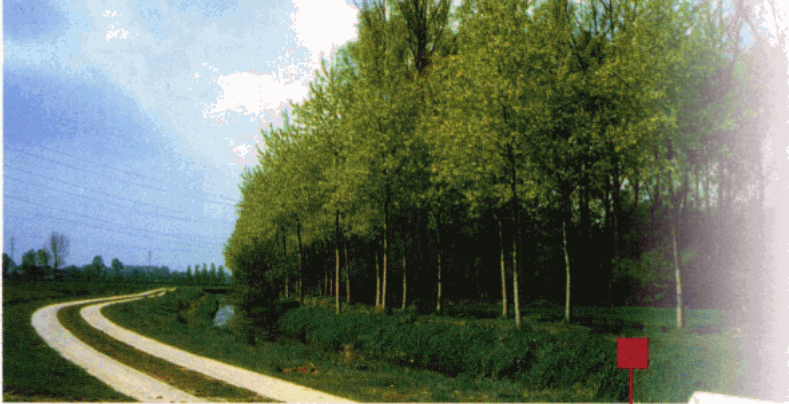
Een nieuw aangelegde tweesporenweg langs de Olentgracht.
