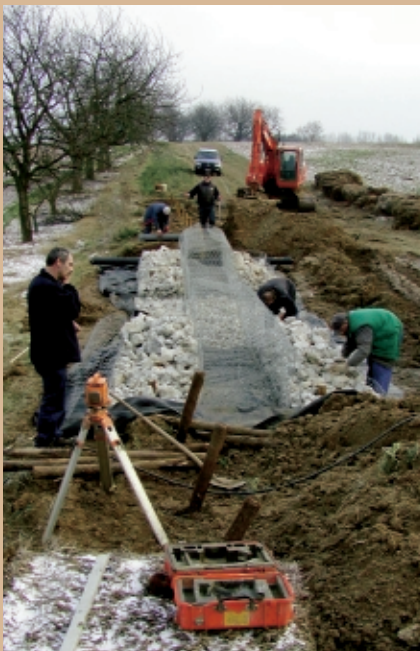
Dam met overloopzone volledig in schanskorven.
