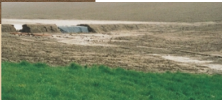
Ondanks de doorbraak van de dam was de schade stroomafwaarts beperkt.
