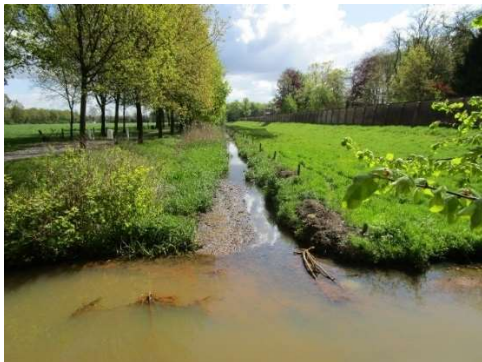
Te herstellen vest aan de noordzijde van de abdiymuren, situatie 2016
