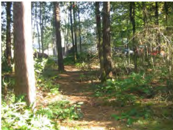
Aanleg wandel-en fietsas door speelbos tussen parking en ontmoetingsplein voor Bosmuseum –foto genomen tegenover Bosmuseum
