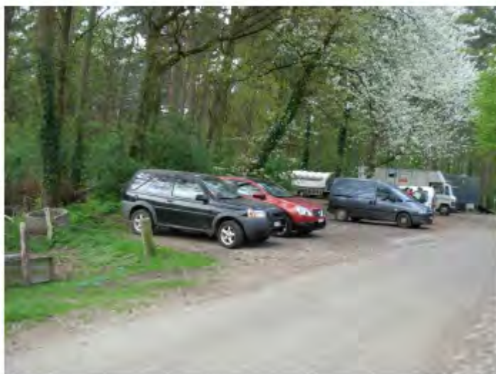
Aanleg trailerparking tegenover horeca Peerdeposterij
