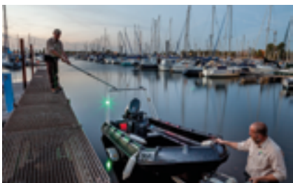
De conclusie na de inspectie is positief.
