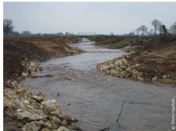
Vispassage in aanleg
