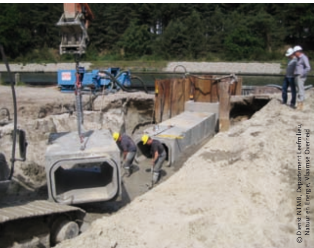
Het plaatsen van de verbindingkokers tussen de paaiplaats en het Kanaal
