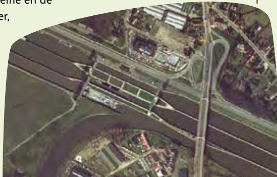
luchtfoto sluisstuwcomplex in Gent
