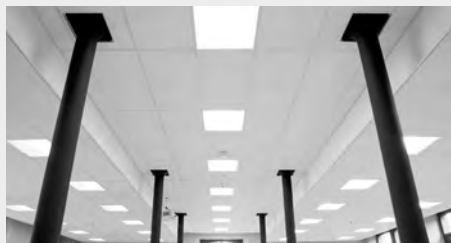
Verlaagd plafond met rotswol platen
