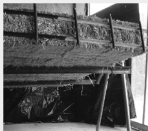
Pre-assemblage van strobalen © Hollis
