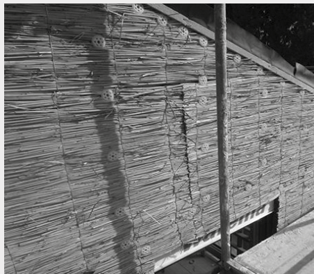
Rietplaten met plugs bevestigd
