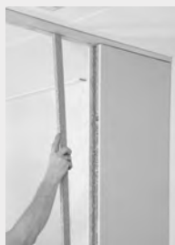
Niet-dragende wanden op basis van vlasseven
