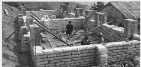
Dragende wanden met los gestapelde earth bags © wolfeintransition
