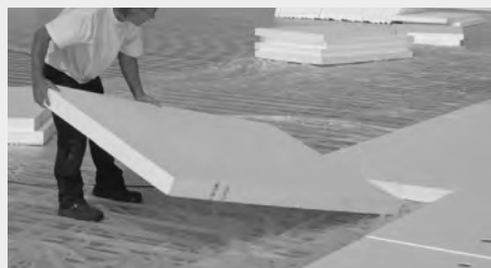
EPS-plaat, mechanisch bevestigd
