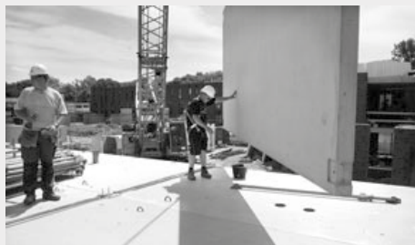
Prefab betonnen wanden © Plegt-Vos
