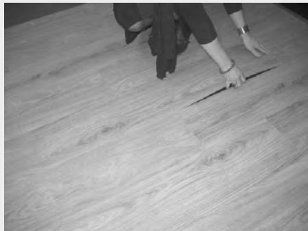
Plaatsing van een magnetische vloerafwerking
