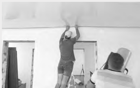
Plaatsing warm spanplafond
