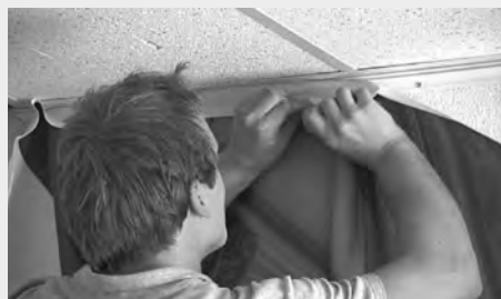
Opspannen van een wandafwerking
