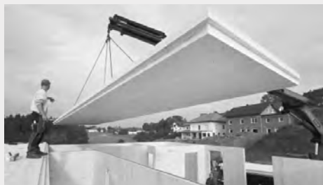
Houten vloerplaten met een rechte liplas
