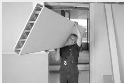
Niet-dragende wanden op basis van karton
