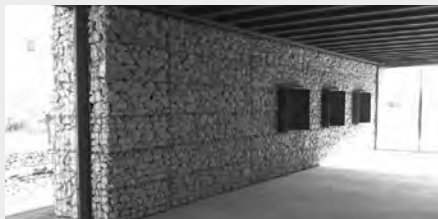
Een dragende wand opgebouwd uit steenkorven © Gabion1
