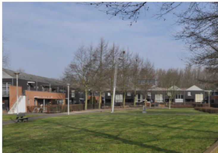
Nijlen, Seringenbos – met de installatie van een collectieve zonneboiler wordt een eerste stap gezet in het prille concept 'duurzaam bouwen'.
