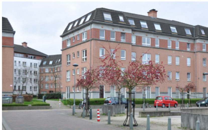
Tienen, Kapucijnenstraat – project Wezenhuis – het gebouw werd gerenoveerd en omgebouwd tot sociale woningen door de SHM Huisvesting Tienen.
