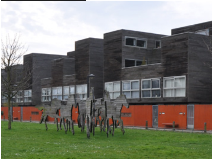
Gent, Brusselsepoortstraat – Hollainhof – 129 appartementen, gefinancierd door het Domus Flandriafonds.
