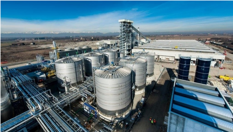
Lignocellulose raffinaderij in Crescentino, Italië. Bron: ETIP Bioenergy
